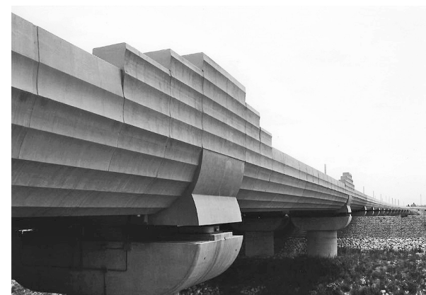
Linea ferroviaria alta velocità, viadotto Modena
